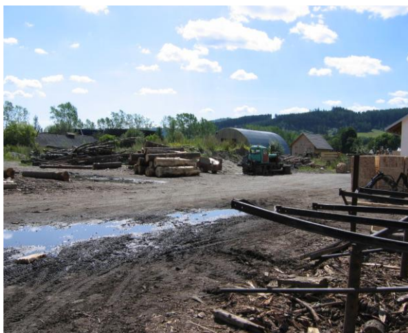
Původní rozbahněný terén
